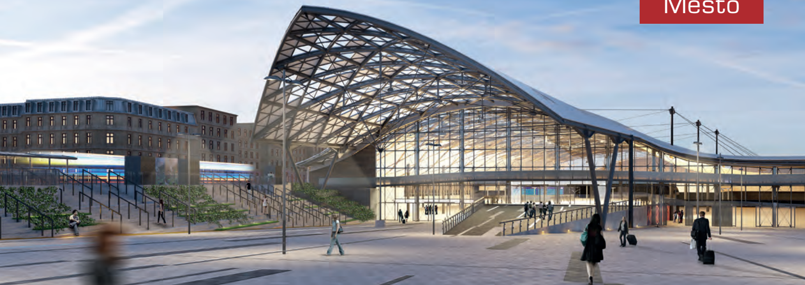
Podzemná železničná stanica Lodž Fabryczna.
