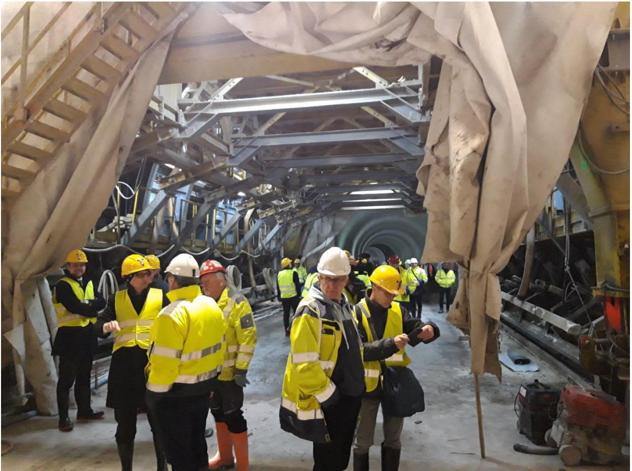
Exkurzia, obhliadka stavebného diela - tunel TD1 a TD2, Wegierska Gôrka
